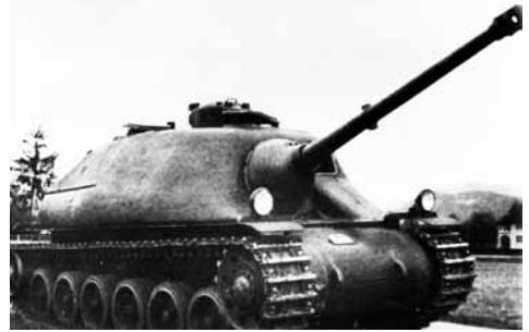
Nahkampfkfkanone II (NKK II), Stand 1946, ausgerüstet mit einer 7,5-cm-Panzerabwehrkanone.
