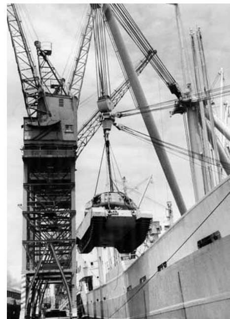
Verlad eines Panzers in Durban mit dem «Derrick»-Kran
