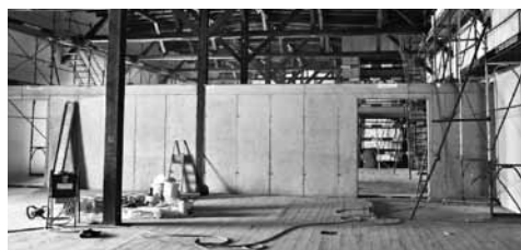
Transformation du bâtiment 118
