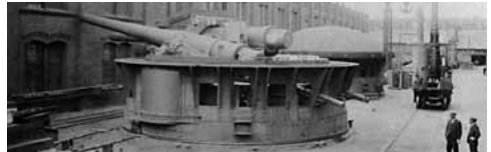
Montage eines Panzerturms für Küstenbefestigung (2x28-cm-Kanonen).
