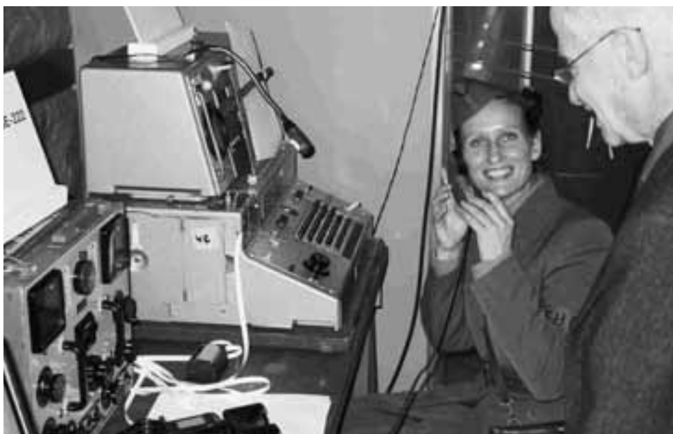
FHD in historischer Uniform vor einem Krypto-Funk-Fernschreiber 58(KFF 58/68) mit Chiffriergerät TC 58/68 im Betrieb
