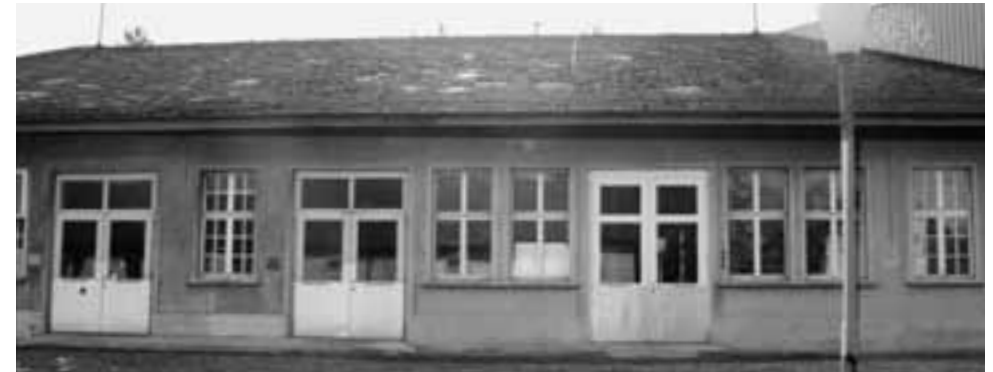
Le bâtiment 848, qui abrite la collection de lampes et de lanternes.
