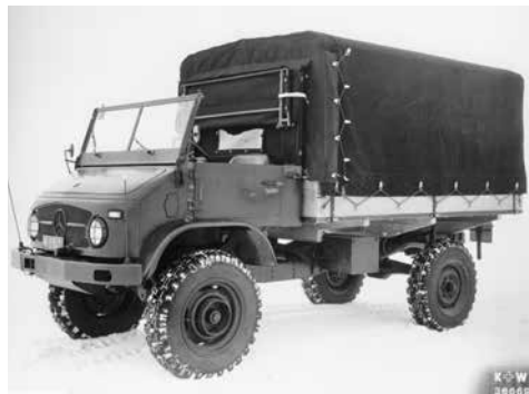
Versuchsfahrzeug M+0841 noch mit Modellpritsche aus Holz.
