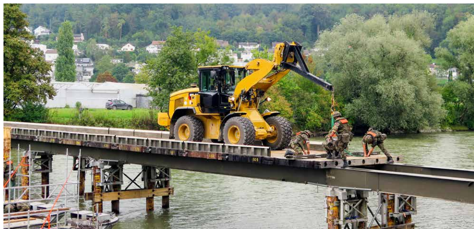
Caterpillar 930K lors de la construction du tablier du pont à poutres d'acier 90.
